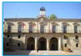
Casa Consistorial Miranda de Ebro, BURGOS
